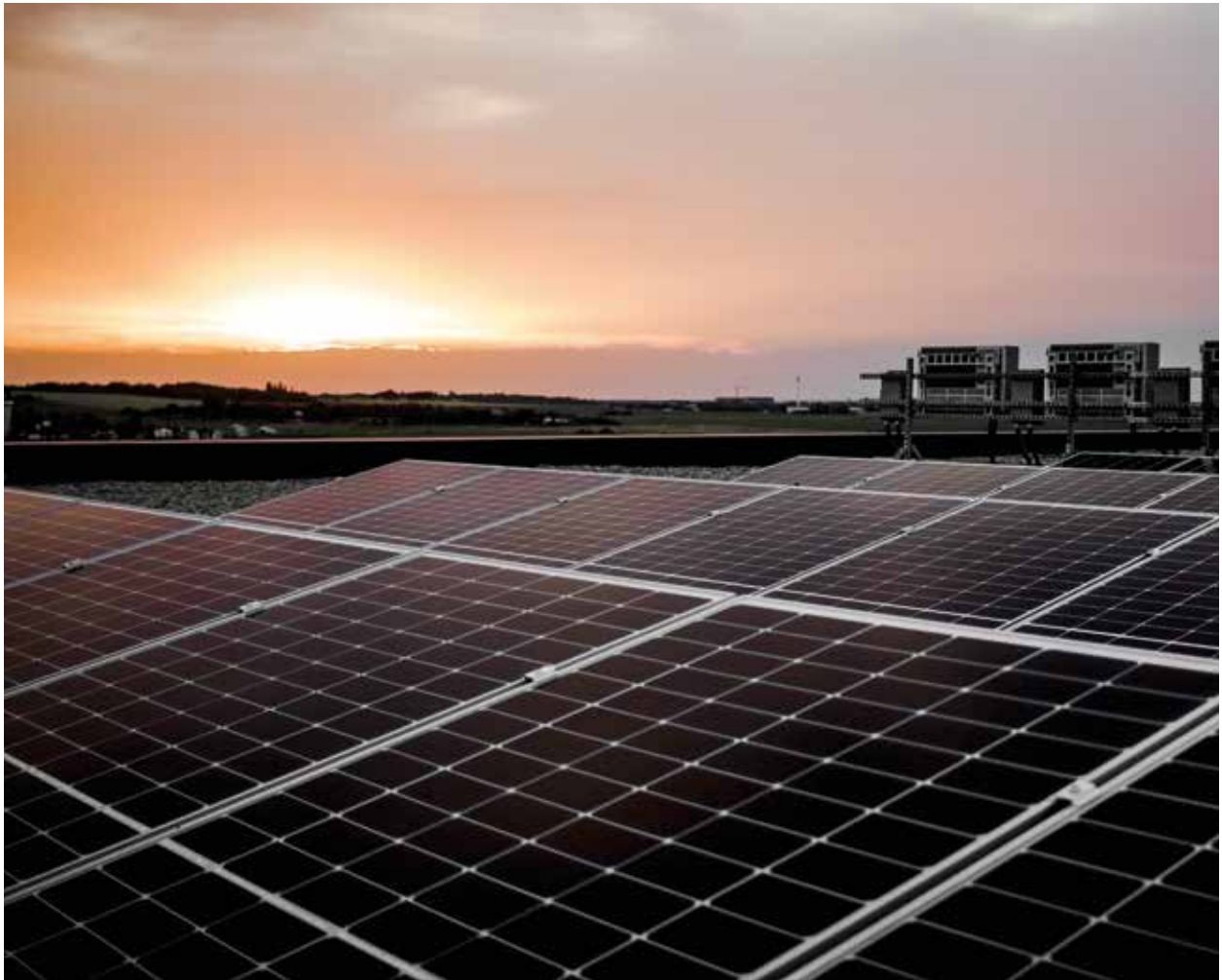
640 Solarpaneele: Blick auf das Dach von Freudenberg Oil & Gas Technologies in Nisku, Kanada
