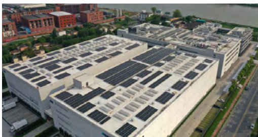
Photovoltaikanlage auf dem Dach der Fabrikgebäude von Freudenberg Filtration Technologies in Shunde, China, 2022
