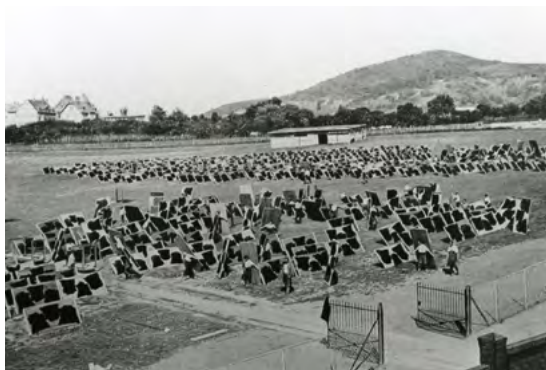
Der Tafelacker an der Lackierfabrik: Die Lackleder-Tafeln werden in der Sonne getrocknet
