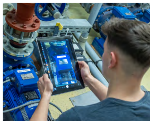
Auslesen von durch den Smart-Seal-Sensor gewonnenen Daten zur Überwachung der Gleitringdichtung, 2023
